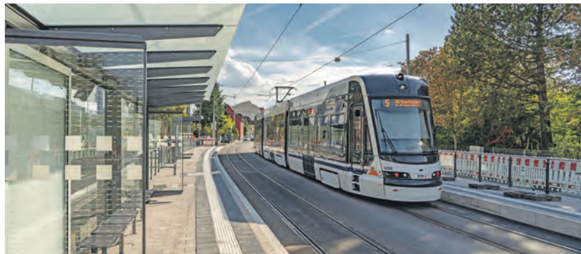
Die Haltestelle Burgstraße wurde im Rahmen der Arbeiten an der Dossenheimer Landstraße neu gestaltet. (Foto rnv/Hauber)
