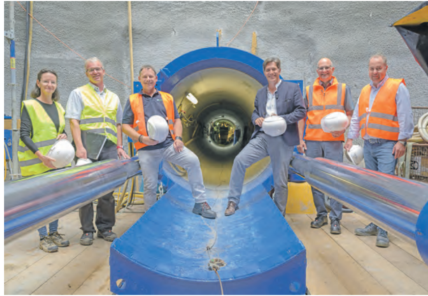
Erster Bürgermeister Jürgen Odszuck (4. von links) mit den Beteiligten bei der Begehung der Baustelle für den neuen Hauptsammelkanal (Foto Rothe)
