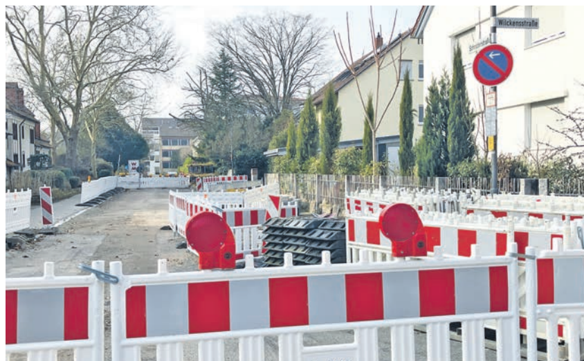
Fernwärme ist eine zukunftssichere, komfortable und krisenunabhängige Wärmeversorgung.
