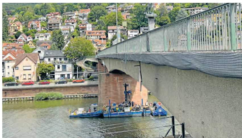
Derzeit wird der Pfeiler auf Ziegelhäuser Seite untersucht. Die Pfeiler sollen möglichst erhalten bleiben. (Foto Stadt Heidelberg)
