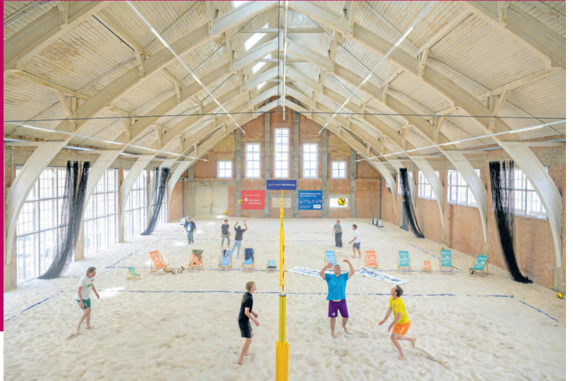
Die Beachhalle ist durch ihre markante Dachkonstruktion, die an einen umgedrehten Schiffskörper erinnert, geprägt. Die historischen Holzsprossenfenster und die Fassadenstruktur blieben erhalten. (Foto Rothe)
