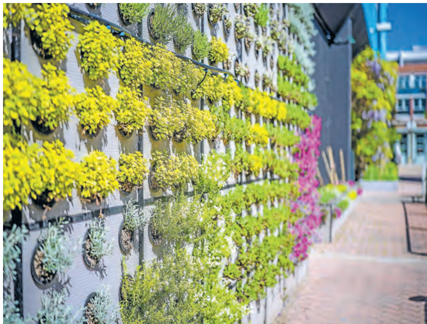
Mitten in Bergheim blüht und summt es: Rund um das Heizwerk wurden zahlreiche Pflanzkörbe und Nistplätze angebracht.
