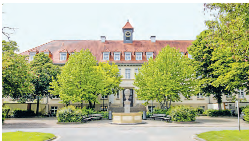
Die Stauffenbergsschule (im Bild) und die Albert-Schweitzer-Schule im Pfaffengrund sollen eine neue Mensa bekommen. (Foto Stadt Heidelberg)
