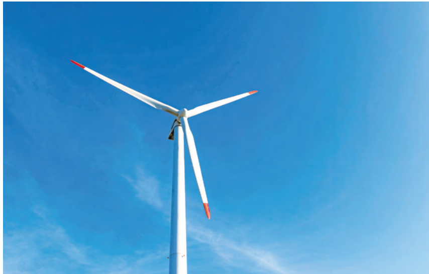
Ein naturschutzfachliches Gutachten sieht auf dem Lammerskopf geeignete Teilbereiche für Windkraftanlagen. (Foto Shutterstock)
