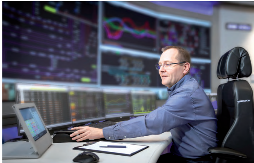
Die Verbundleitstelle der Stadtwerke Heidelberg Netze hält das Heidelberger Stromnetz rund um die Uhr im Blick und ist Ihr Ansprechpartner bei Störungen im Stromnetz.
