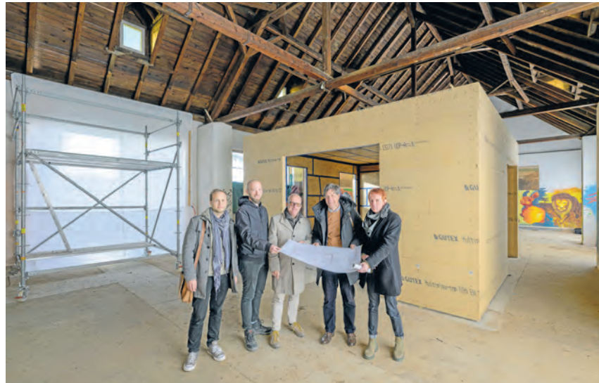
Eine Haus-in-Haus-Lösung ermöglicht eine vielfältige Nutzung der Chapel. Erster Bürgermeister Jürgen Odszuck (2. v. r.) besuchte mit Beteiligten die Baustelle. (Foto Rothe)
