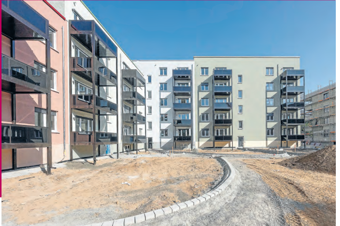
Die GGH baut derzeit 191 Mietwohnungen mit ein bis fünf Zimmern für Haushalte mit unterem und mittlerem Einkommen. Die Innenhöfe und Grünflächen werden noch gestaltet. (Foto Buck/GGH)
