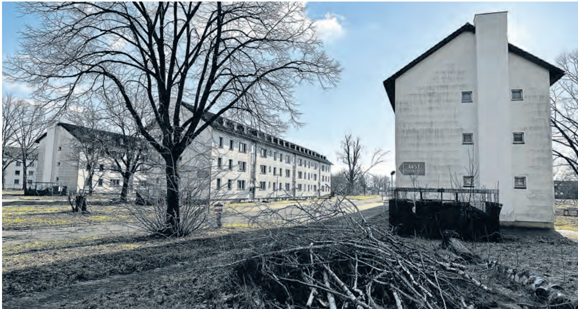
Auf PHV wurden die ersten Gebäude auf wiederverwertbares Material geprüft. Das Ergebnis: Allein auf einem Baufeld mit rund 30 Bestandsgebäuden wird mit rund 465.880 Tonnen an Rohstoffen gerechnet. (Fotos Stadt Heidelberg)
