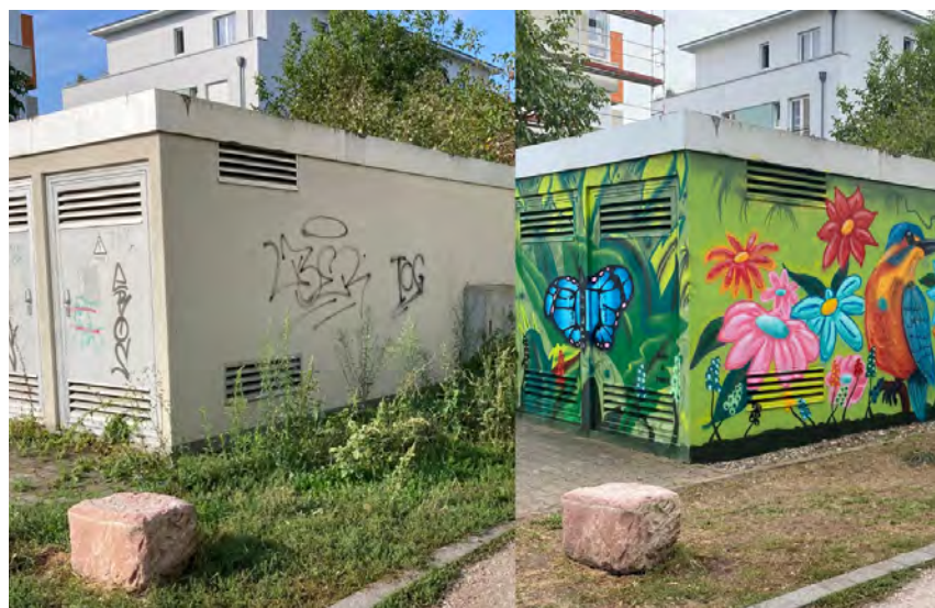
Neun Jugendliche gestalteten im September ein Trafohäuschen in Rohrbach dank Förderung durch das Stadtteilbudget neu. (Foto Stadt Heidelberg)
