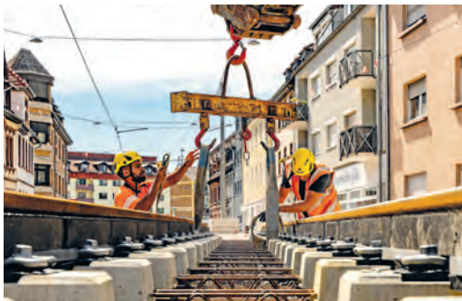
1. August Dossenheimer Landstraße Die Gleisarbeiten an der Dossenheimer Land- straße beginnen. Die Verkehrsader in Hand- schuhsheim wird seit März neu gestaltet.
