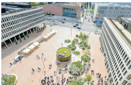
13. September Eröffnung Europaplatz Der Europaplatz am Südausgang des Haupt- bahnhofs wird eröffnet. Hier gibt es Bänke, 29 Bäume und einen Trinkwasserbrunnen.
