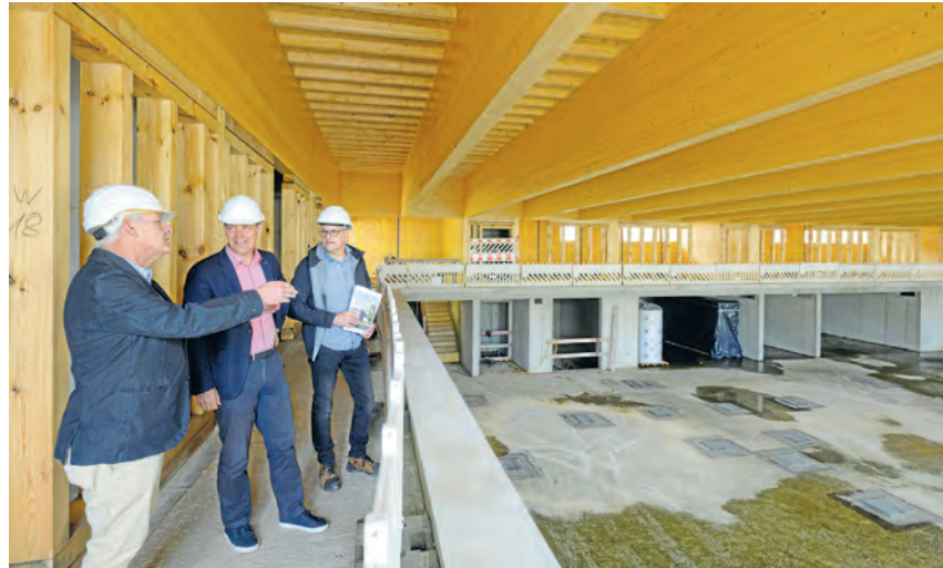
Mit großen Schritten geht der Neubau der Sporthalle der Geschwister-Scholl-Schule voran. EBM Jürgen Odszuck (M.) machte sich kürzlich ein Bild vor Ort. (Foto Rothe)
