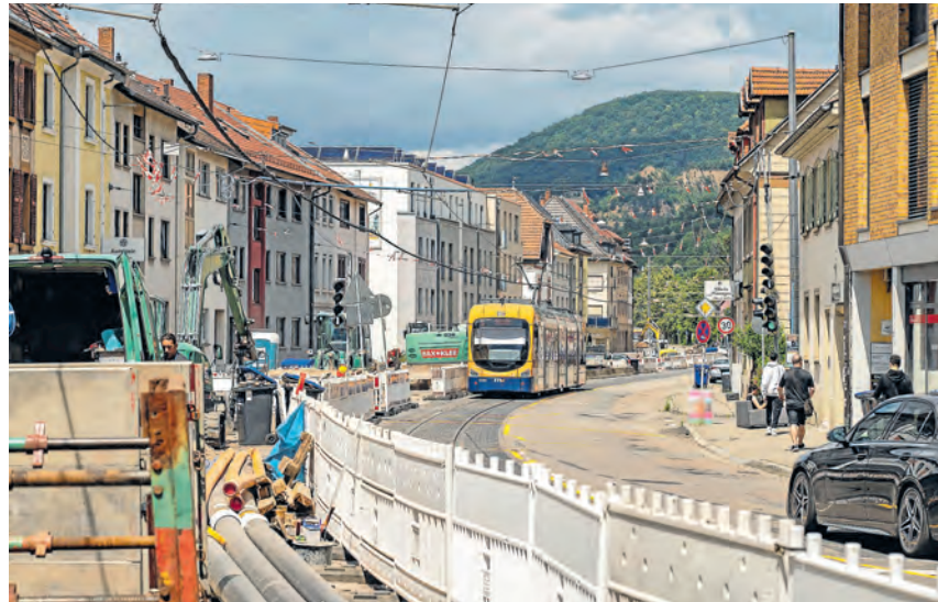
An der Dossenheimer Landstraße beginnen die Gleisarbeiten. (Foto rnv / Haubner)
