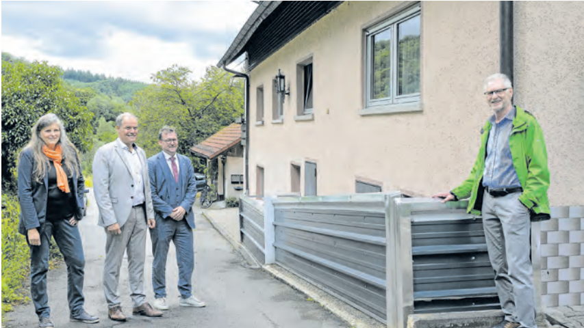
Egon Müller (r.) zeigte OB Eckart Würzner (2.v.l.), Klimabürgermeister Raoul Schmidt-Lamontain und Umweltschutzleiterin Sabine Lachenicht die neue Schutzwand. (Foto Rothe)
