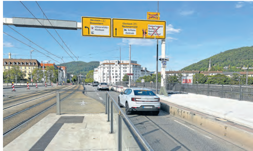
Aufgrund der Bauarbeiten fährt die Straßenbahn nach den Pfingstferien eine Umleitung und nicht über die Montpellierbrücke. Rad- und Gehweg stadteinwärts sind fast fertig.
