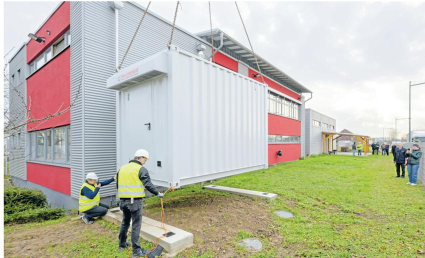
Die circa 6,5 Tonnen schweren Container wurden mit einem Autokran abgestellt. Ein Notstromaggregat kann ein Feuerwehrhaus drei Tage mit Strom notversorgen. (Foto Rothe)
