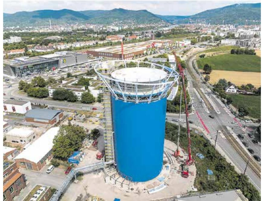
Wie eine Thermoskanne speichert der Energiespeicher verfügbare oder überschüssige Energie als Wärme und verteilt sie, wenn sie gebraucht wird. (Foto Stadtwerke)
