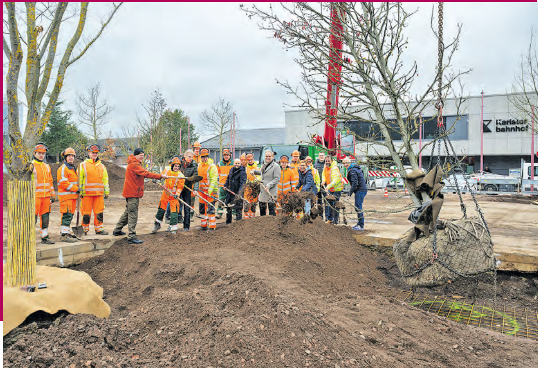
Einer von 14: Mit einem Spezialkran wird ein 30 Jahre alter Amberbaum in sein gewaltiges Pflanzloch auf dem Marlene-Dietrich-Platz gehoben. (Foto Rothe)
