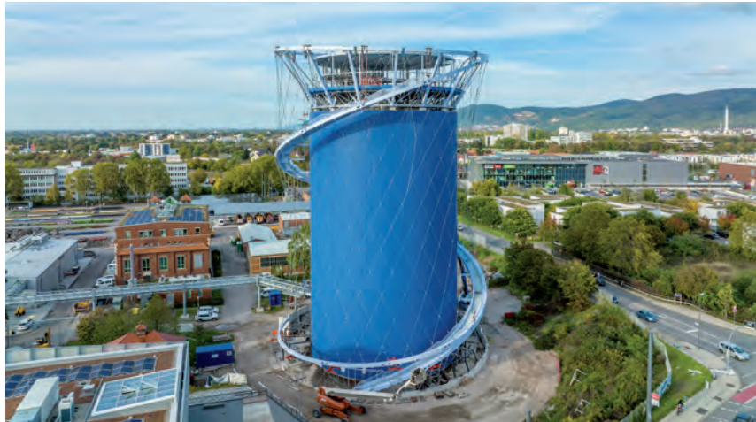
Die Helix-Treppe führt nach oben auf das Dach des 55 Meter hohen Energie- und Zukunftsspeichers.
