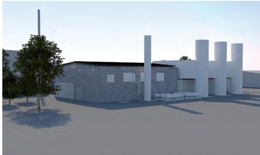
Rechts die drei Lufttürme, über die reine, aber abgekühlte Luft entlassen wird, links der Schornstein der Blockheizkraftwerke.
