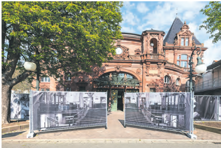
Die Stadthalle wird im Inneren umfassend saniert und erfüllt künftig die Anforderungen an ein modernes Konzert- und Kulturhaus. (Foto Buck)
