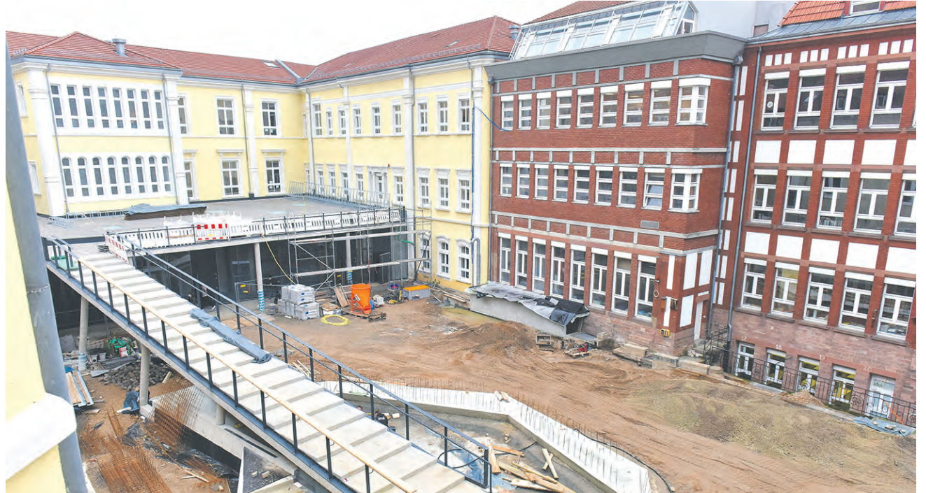
Mehr als 25 Millionen Euro fließen in die Sanierung der Schulen. So wird unter anderem das Hölderlin-Gymnasium generalsaniert. (Foto Dorn)
