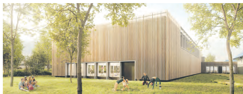
Die neue Trainingshalle entsteht in Holzbauweise und im Passivhaus-Standard. (Foto motorplan Architekten und Ingenieure)
