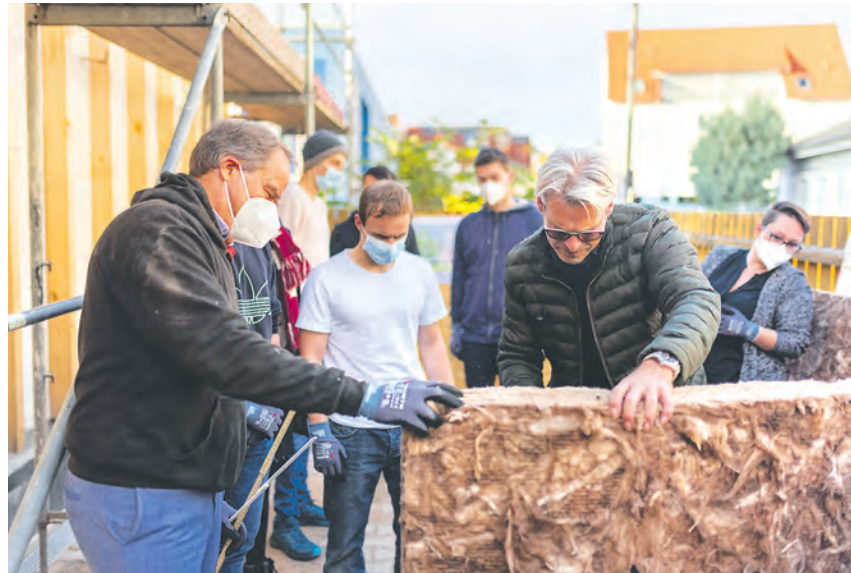
Gemeinschaftswerk: OB Prof. Würzner (links) schnitt das Dämmmaterial auf die richtige Größe zu, die Jugendlichen brachten es auf der Wand an. (Foto Dittmer)
