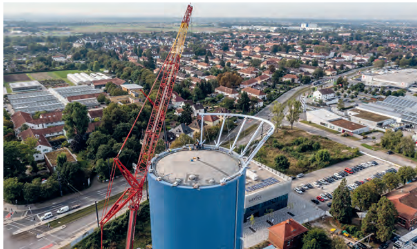
Für die Arbeiten werden Personen und Materialien per Kran auf 45 Meter Höhe gebracht.
