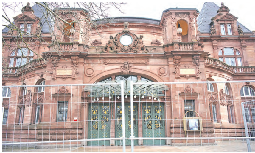
Auch wenn die Sanierungsarbeiten im Inneren erfolgen, ist zum Schutz rund um die Stadthalle ein Bauzaun erforderlich. (Foto Stadt HD)
