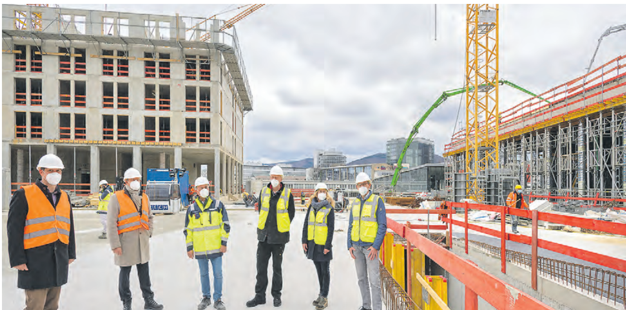
Beim Rundgang über die Großbaustelle am südlichen Bahnhof (im Hintergrund): Erster Bürgermeister Jürgen Odszuck (l.), Oberbürgermeister Prof. Dr. Eckart Würzner (2.v.l.) und Kai M. Dreesbeimdiek, Geschäftsführer der Gustav Zech Stiftung (3.v.l.). (Foto Rothe)
