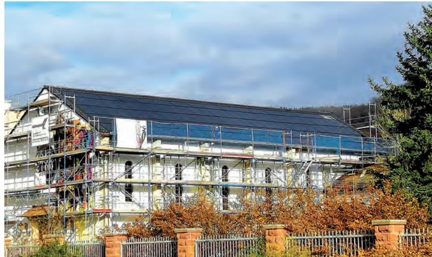
130 Photovoltaik-Module auf dem Dach der Chapel: die erste dachintegrierte Photovoltaik-Anlage auf einem denkmalgeschützten Gebäude der Stadt Heidelberg.
