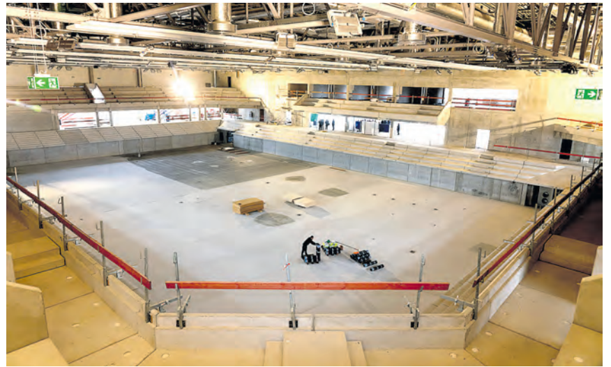
Der Bau der Großsporthalle schreitet voran. Aktuell wird die Haustechnik installiert und es laufen die Vorarbeiten für die Verlegung des Hallenbodens. (Foto Buck)
