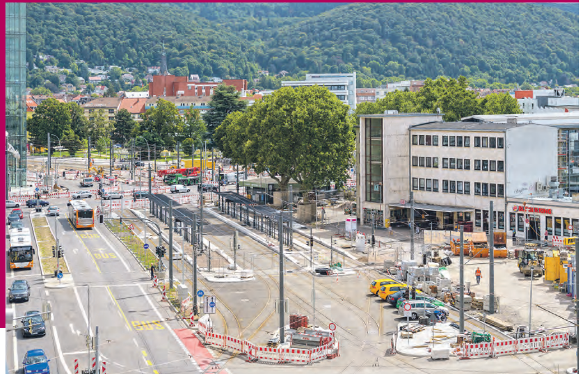
Jetzt ist rasches Umsteigen bequemer möglich: Der Haltebereich von Bussen und Bahnen ist an den Hauptbahnhof herangerückt und mit jetzt vier Gleisen auch leistungsfähiger. (Foto Rothe)
