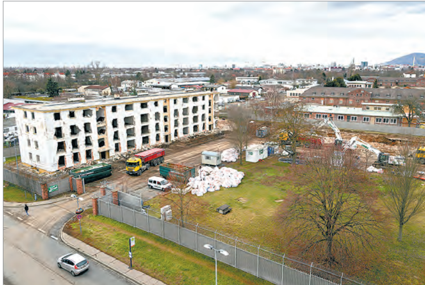
Der letzte der vier Wohnblocks am Sickingenplatz wird noch im Februar abgerissen. Im Mai soll der Bau neuer Wohnungen und eines Polizeigebäudes beginnen. (Foto Rothe)
