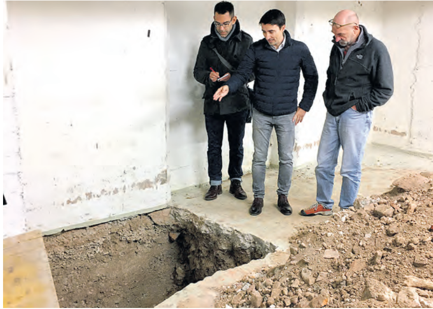
Die Fundamente der Stadthalle reichen über sieben Meter in den Boden und sind tiefer, als ursprünglich angenommen. Das zeigen Untersuchungen im Keller. (Foto Stadt HD)
