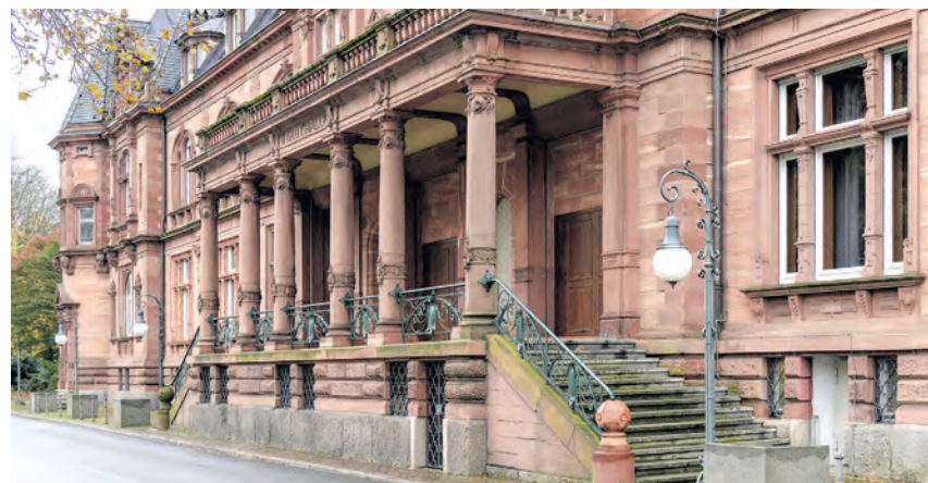
Der Säulengang an der B 37 wird verglast, die ursprünglichen Öffnungen in der Fassade freigelegt: Besucher haben dann wieder freien Blick auf den Neckar. (Foto Rothe)
