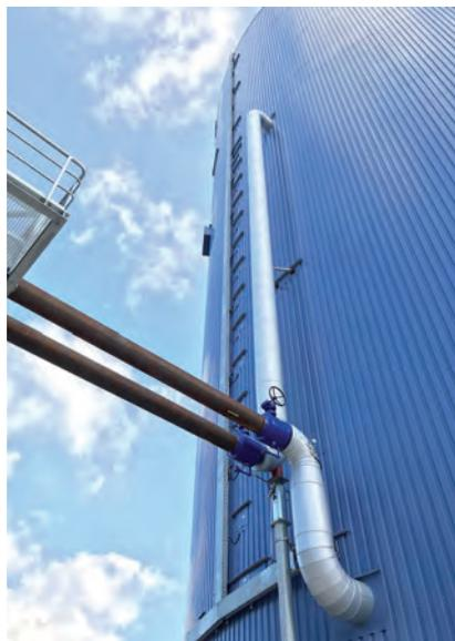
Seit kurzem ist der Energie- und Zukunftsspeicher mit dem Fernwärmenetz verbunden. Der Speicher ermöglicht es, Wärme zu speichern und bereit zu stellen, wenn sie gebraucht wird.
