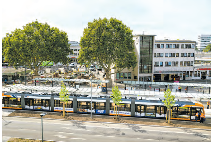
Die neue Haltestelle Hauptbahnhof ist nun direkt vom Bahnhof aus zu erreichen, ohne dabei eine Straße queren zu müssen (Foto Rothe)
