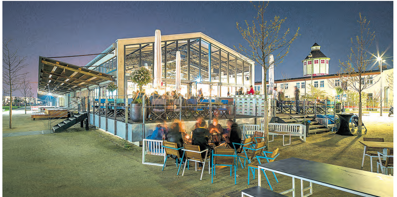
„Hier ist es beispielhaft gelungen, einen identitätsstiftenden Baukörper mit einfachen Mitteln umzunutzen“, würdigt die Jury den Umbau der Halle 02 in der Bahnstadt. Architekten: ap88 und AAg Loebner Schäfer Weber (Foto Ross)
