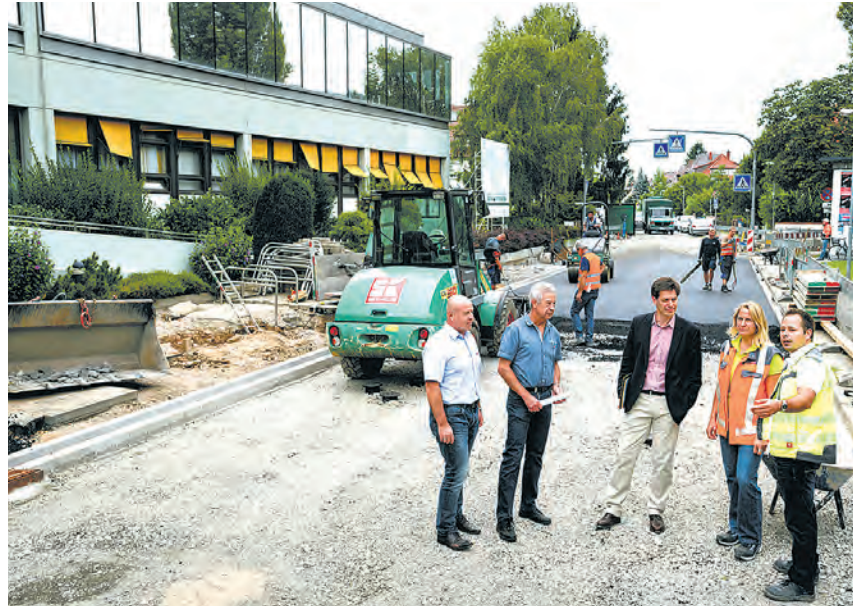
Erster Bürgermeister Jürgen Odszuck (Mitte) informierte sich über die Bauarbeiten in der Zeppelinstraße beim Krankenhaus Salem. (Foto Rothe)
