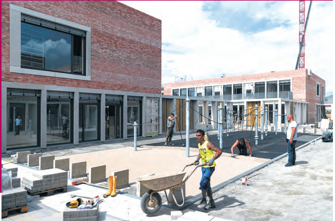
Endspurt bei der Errichtung des Bildungs-, Betreuungs- und Bürgerhauses B 3 in der Bahnstadt. Zum Schuljahresbeginn ziehen hier Jungen und Mädchen in die Grundschule ein. (Foto Rothe)
