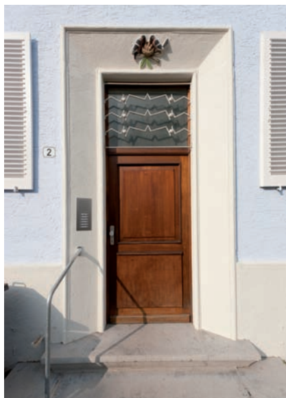
Historische Tür im denkmalgeschützten Altbau
