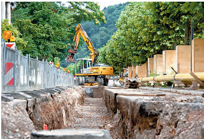
Freie Bahn für den Bagger, dann geht alles viel schneller.
