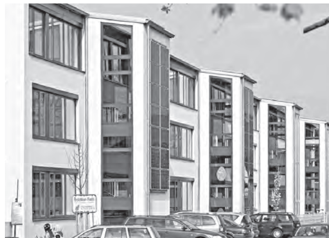
Albert-Schweitzer-Schule nach Abschluss der Sanierung. Foto: Rothe
