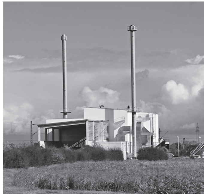
Foto: MVV Energie AG
