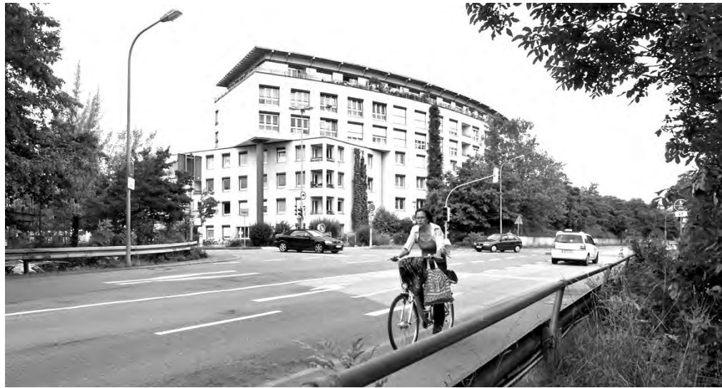
Am 20. Juli beginnen die Bauarbeiten am Hauptsammelkanal West in der Ludwig-Guttman-Straße. Dieser erste Bauabschnitt soll innerhalb eines Jahres abgeschlossen sein. Foto: Rothe
