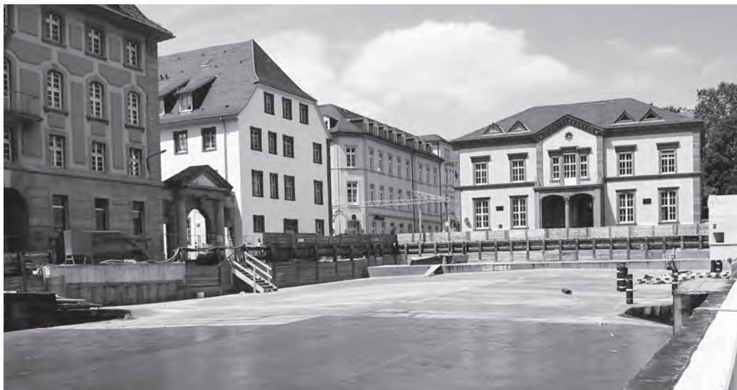
Hier erfolgt nach Beendigung der Arbeiten die Oberflächengestaltung
