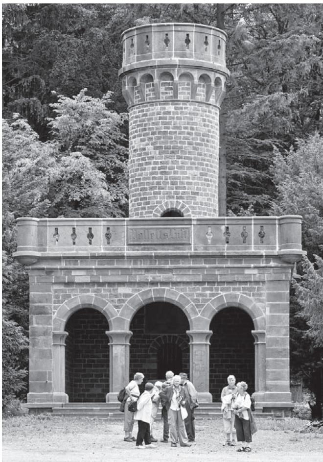
Wieder ein Hingucker: Der Posseltlust-Turm auf dem Kohlhof wurde saniert. Das wird am 28. Juni mit einem Fest gefeiert. Foto: Rothe
