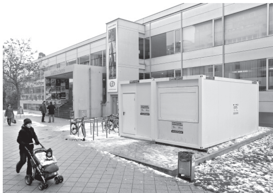
Bücherei kompakt: Im Container vor der Hauptstelle der Stadtbücherei in der Poststraße gibt es während der Sanierungszeit Bestseller und Beratung.
