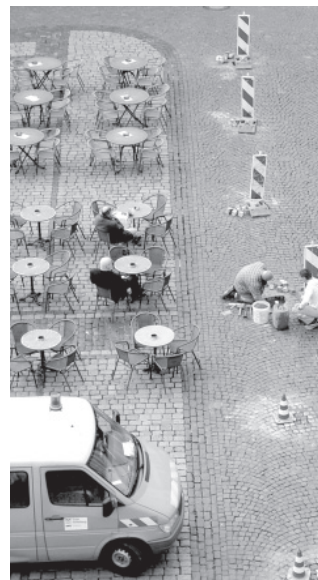
Mitarbeiter des Tiefbauamtes beim Setzen der Bodenhülsen.
