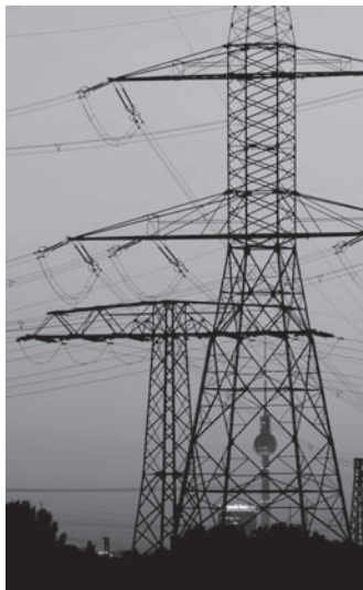
Die Versorgung mit Strom ist für uns eine Selbstverständlichkeit
