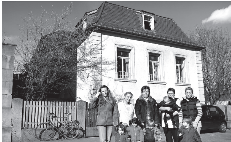
Die Kindertagesstätte in der Vangerowstraße wird ab Mitte des Jahres aufwändig saniert und bleibt rund zwölf Monate geschlossen. Foto: Rothe
