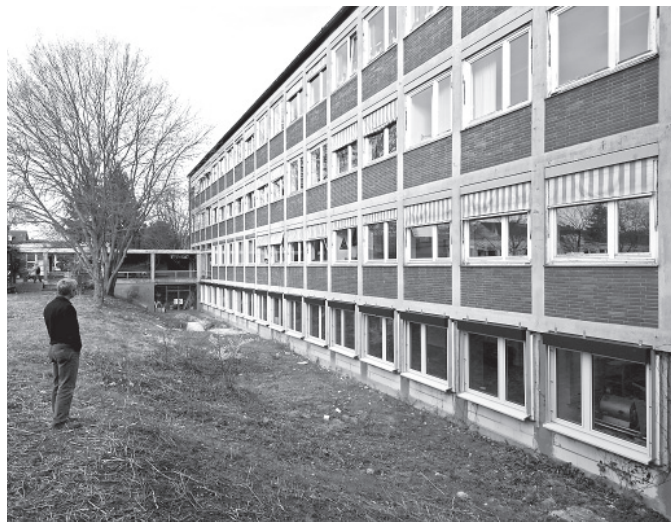
Der S-Bau der Geschwister-Scholl-Schule in Kirchheim wird außen und innen saniert. Foto: Rothe
