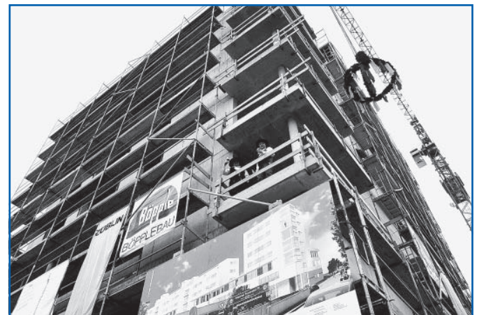
„Stadtresidenz“ feierte Richtfest. Acht Monate nach der Grundsteinlegung schwebt bereits der Richtkranz über dem imposanten Neubau auf dem Gelände der ehemaligen Landeszentralbank zwischen Poststraße und Kurfürsten-Anlage. Die „Stadtresidenz am Park“, die die Reinhard Unternehmensgruppe aus Sandhausen erstellt, wird ab Herbst 70 Seniorenwohnungen, eine Station für Demenzerkrankte mit 24 Plätzen und im Erdgeschoss einen Aldi-Markt beherbergen. Dort sind auch Büro- und Schulungsräume des Paritätischen Wohlfahrtsverbandes sowie ein für die Öffentlichkeit zugängliches Bistro vorgesehen. Jörn Fuchs, Geschäftsführer der Paritätischen Sozialdienste Heidelberg, berichtete, dass sich für ein Drittel der 55 bis 100 Quadratmeter großen Ein- und Zweizimmer-Apartements bereits Mietinteressenten gefunden haben. Weitere Informationen findet man unter www.stadtresidenz-heidelberg.de . Foto: Dorn
