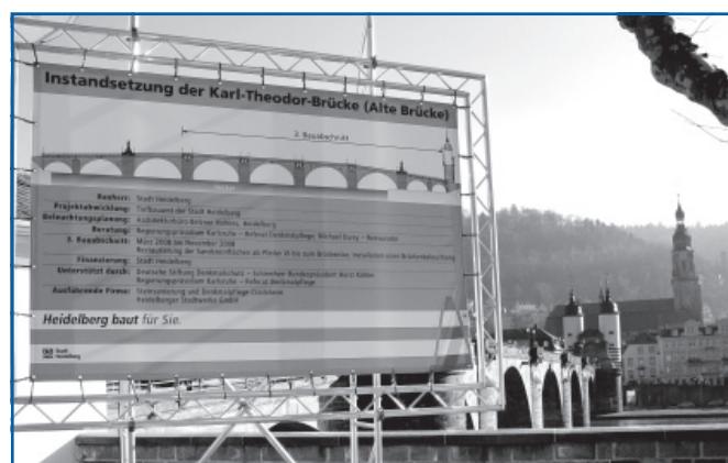
Sanierung geht weiter. Am 3. März beginnt der dritte und letzte Bauabschnitt der Sanierung der Alten Brücke. Im Zuge dieser Arbeiten wird auch die neue Beleuchtung installiert. Die Brücke muss während der gesamten Bauzeit für den Kraftzeugverkehr gesperrt werden. Fußgänger können die Brücke weiterhin nutzen. Die Bauarbeiten werden voraussichtlich bis November dauern. Foto: Stadt Heidelberg
