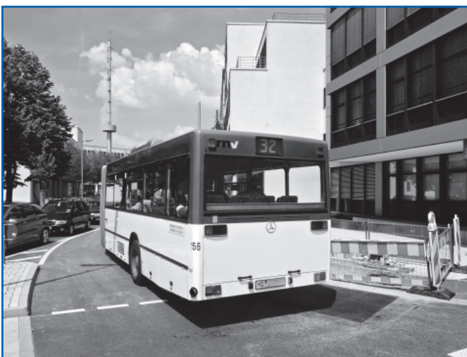
Problem behoben. Die RNV-Gelenkbusse hatten Schwierigkeiten, von der Kurfürsten-Anlage in die Römerstraße abzubiegen, ohne in den Bereich des Gegenverkehrs zu geraten. Dieses Problem hat das Tiefbauamt in den Pfingstferien durch Umbau des Einmündungsbereichs der Römerstraße behoben. Die Umleitung über den Hauptbahnhof besteht nicht mehr. Foto: Rothe
